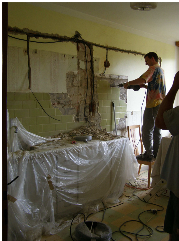
Naše kuchyň při rekonstrukci elektřiny
